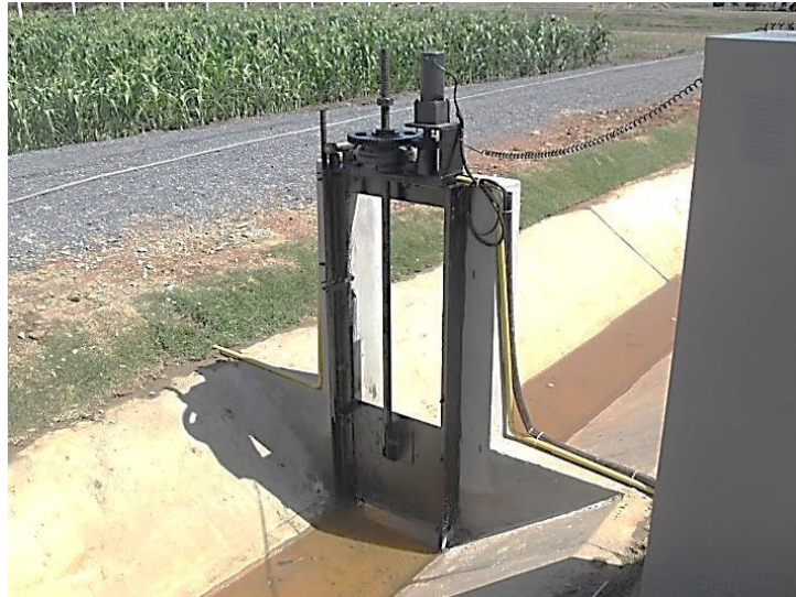
รูปที่ ๔ แสดงการติดตั้งบานฝาท่อ
