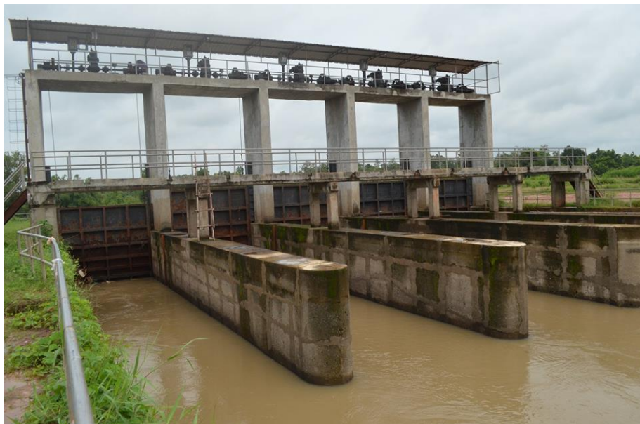
รูปที่ ๒ แสดงเหล็กโครงสร้างบาน เหล็กร่องบาน และชะเนาะเกลียว
