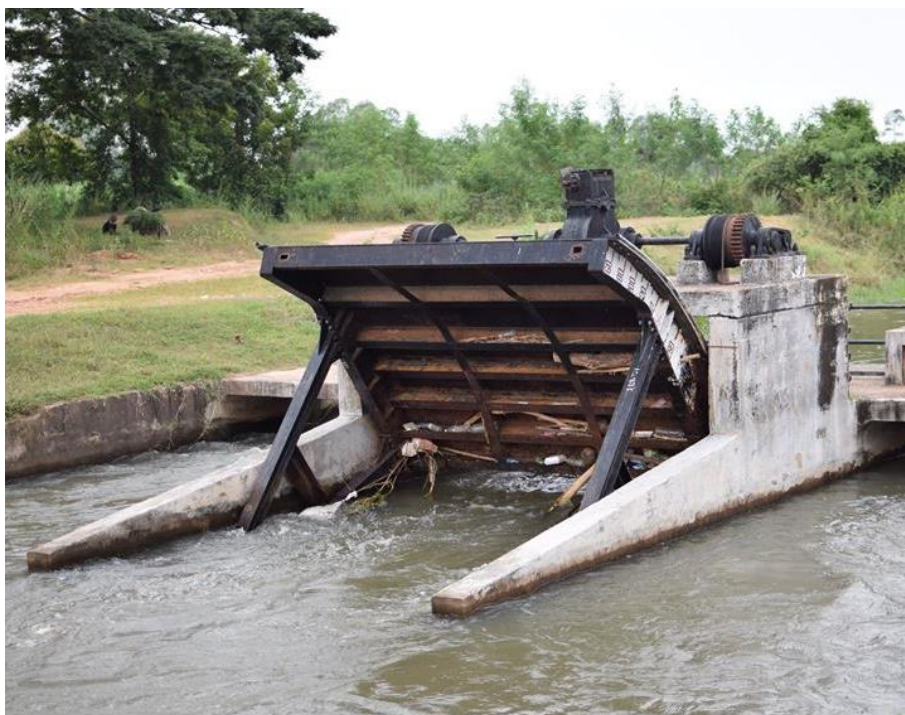
รูปที่ ๓ แสดงการติดตั้งบานระบายโค้ง
